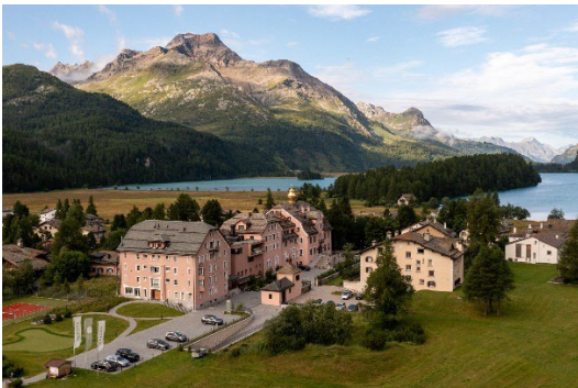
Nordansicht auf heutige Anlage mit Personalhaus und Wellnessbereich im Vordergrund. Foto Parkhotel Margna
